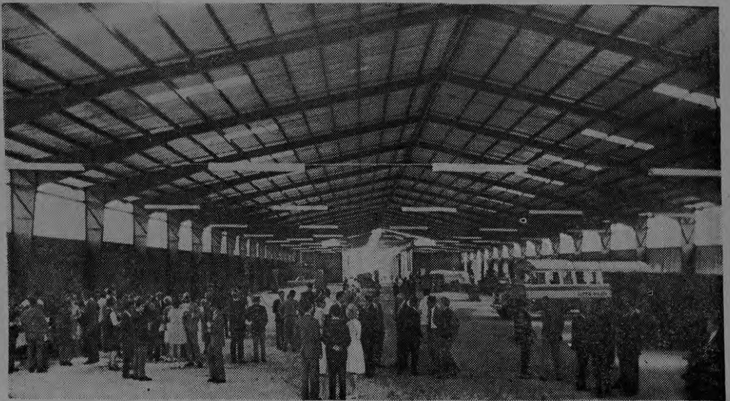
Se pueden admirar las inmensas instalaciones de la fábrica COTICA S.A., que el viernes, al mediodía inauguró su sede en el Barrio San José, de Alajuela. Las estructuras de acero fueron fabricadas por Espreca, cuyo gerente es el Ing. Claudio Ortiz Guier.
